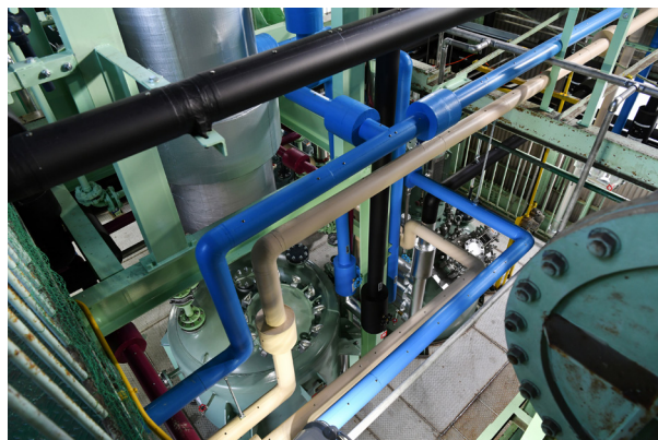
原料を化学反応させる反応釜（上）が複数設置される工場内は、釜に温水や冷水などを供給する配管が張り巡らされている（下）。
